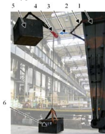
Rys. 4. Sprawdzenie metodą zastępczą odporności na działanie wiatru od czoła na przęsło w położeniu pionowym
