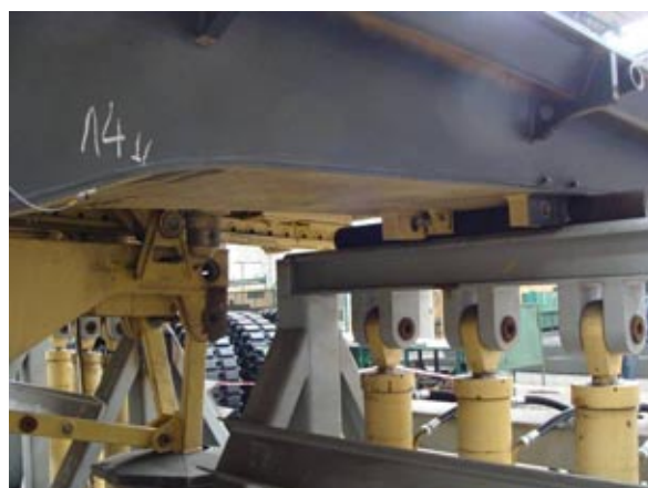
Tens. t14 – prawy dolny pas segmentu najazdowego przęśla głównego
