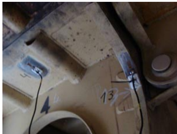
Tens. t4 i t13 – spód jezdni i pionowa ścianka segmentu środkowego przęśla głównego
