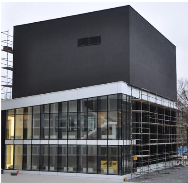
Rys. 4. Budynek LZWP w końcowej fazie budowy (fot. J. Lebieź)
