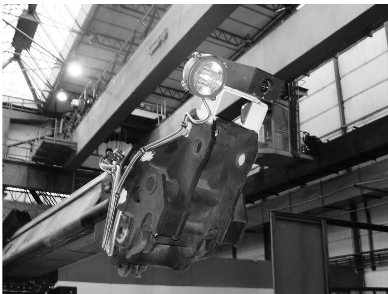
Rys.3. Montaż kamery wąskokątnej wraz z reflektorem na członie wysuwym wysięgnika
