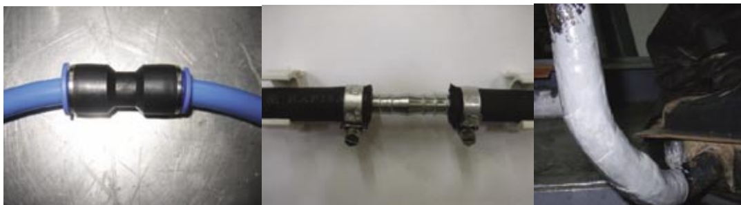
Rys. 6. Przykłady metod naprawy przewodów za pomocą szybkozłączek (z lewej) i kompozytów klejowych (z prawej)
