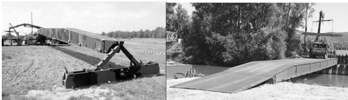
Rys. 3. Przęsło pomocnicze z belką brzegową i gotowy most z najazdem [13]
