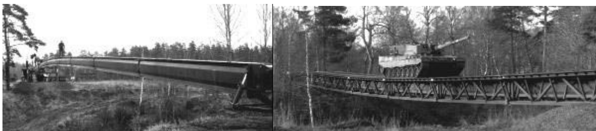
Rys. 7. Widok wysuniętego na przeciwległy brzeg blachownicowego przęsła pomocniczego i kompletnego mostu FB 48 na przeszkodzie (między kratowymi dźwigarami przęsła pomocnicze) [18]
