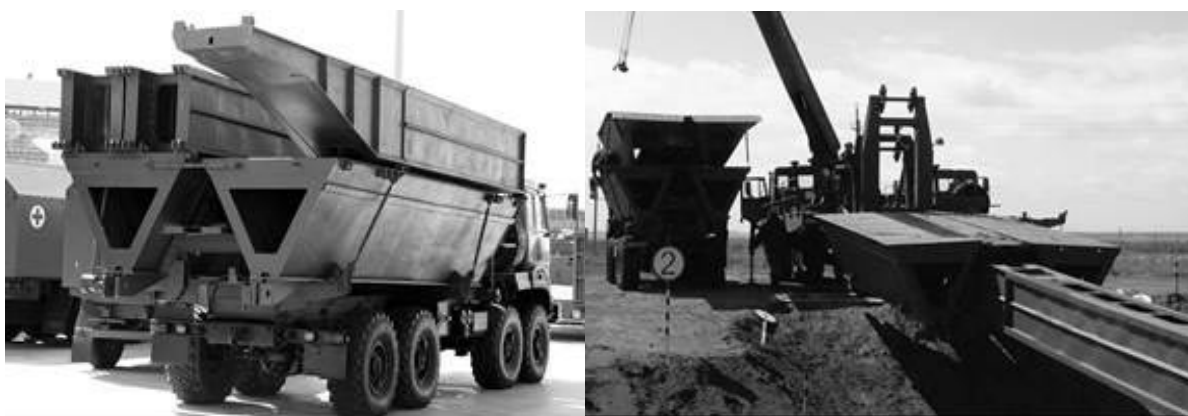
Rys. 11. Widok segmentów mostu i przęsła pomocniczego w położeniu transportowym oraz montaż segmentów przęsła MMK na przęsło pomocniczym [21]
