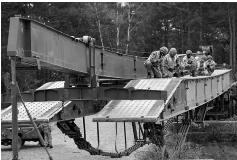
Rys. 12. Budowa mostu GSB z widocznym pod przęsłem systemem wzmocniającym [26]
