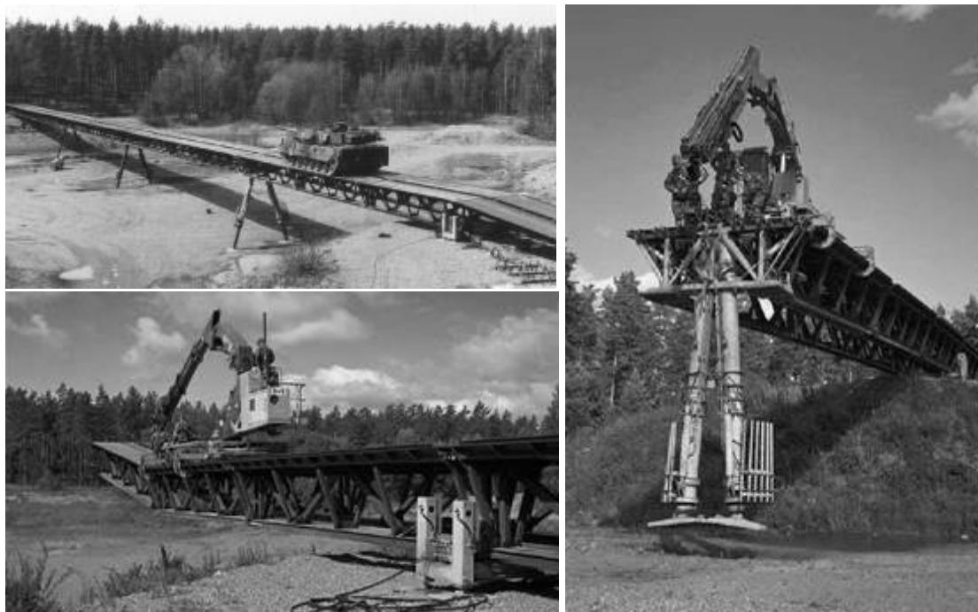
Rys. 9. Most FB 200 na przeszkodzie terenowej i widok wspornikowego montażu segmentów przęsła i podpory za pomocą specjalnego układacza [18]
