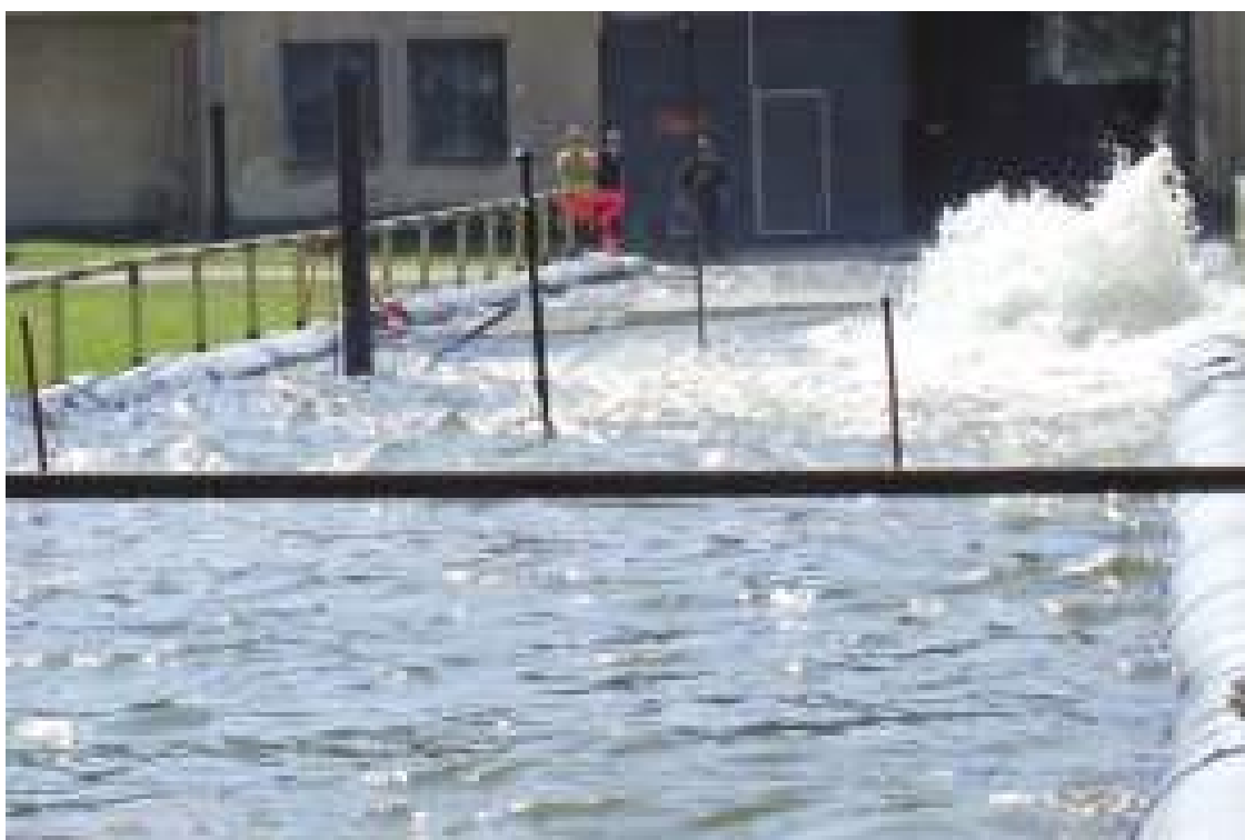
Rys. 7. Podniesienie tylnej części mostu [2]
